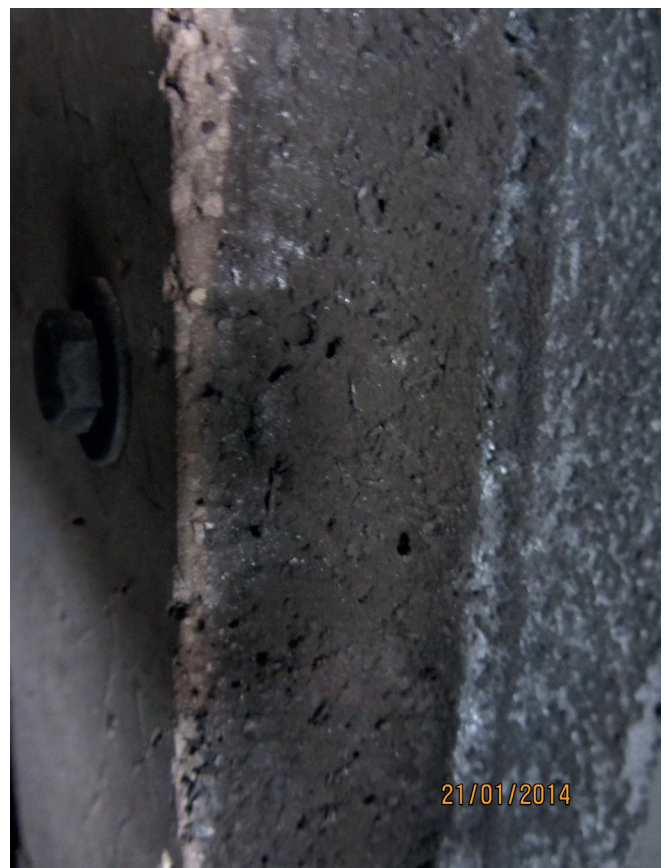
Bild 4: Schamottwand mit Verschraubung
