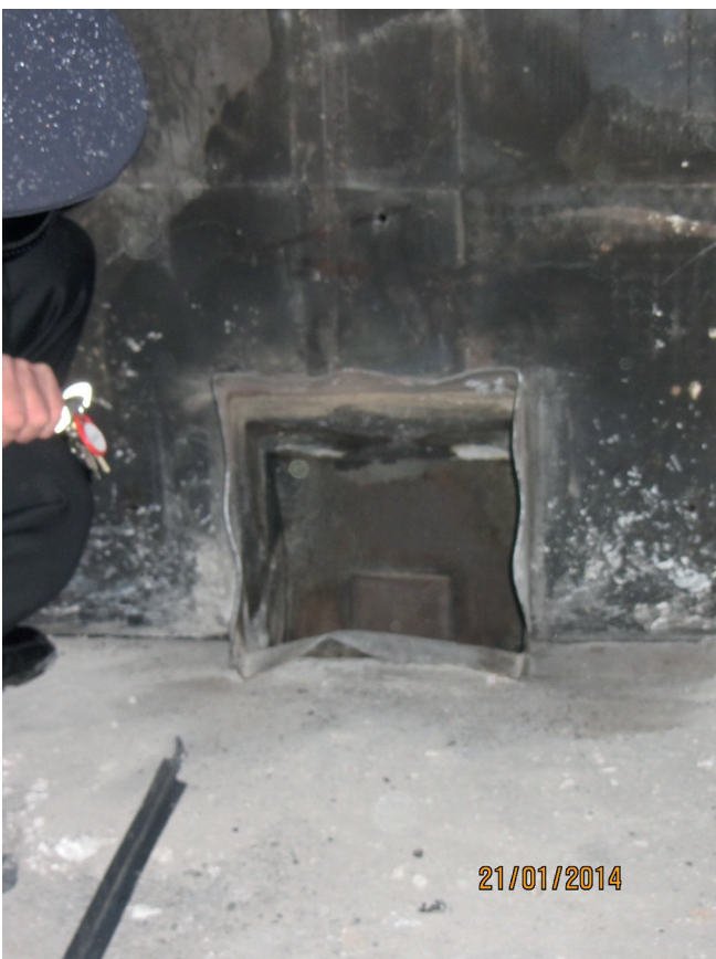
Bild 3: Druckentlastungsvorrichtung, innen
